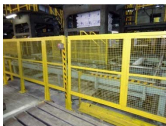
ロールコンベアの防護柵
